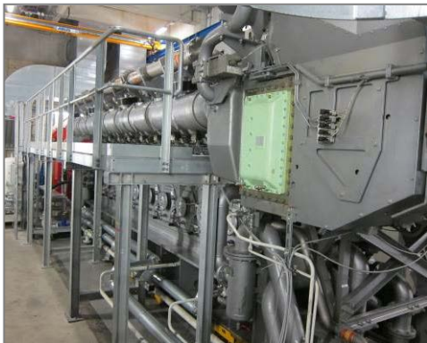
Bild links: MAN 20V 35/44G Motor im VW KWK-Kraftwerk in Braunschweig
