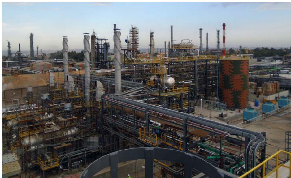
Die Raffinerie von ARL in Rawalpindi, Pakistan.
