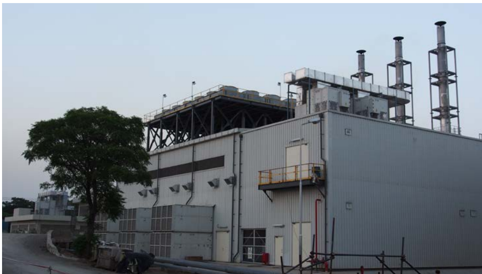
Powerhouse des Kraftwerks
