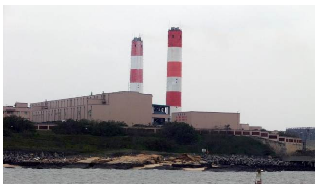
中国台湾金门岛塔山电厂的当前状态
