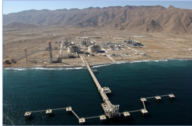
LNG-Anlage Qalhat der Oman LNG
