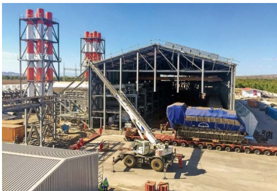
Einer von insgesamt acht MAN 18V48/60 Motoren bei der Ankunft in Los Brasiles.
